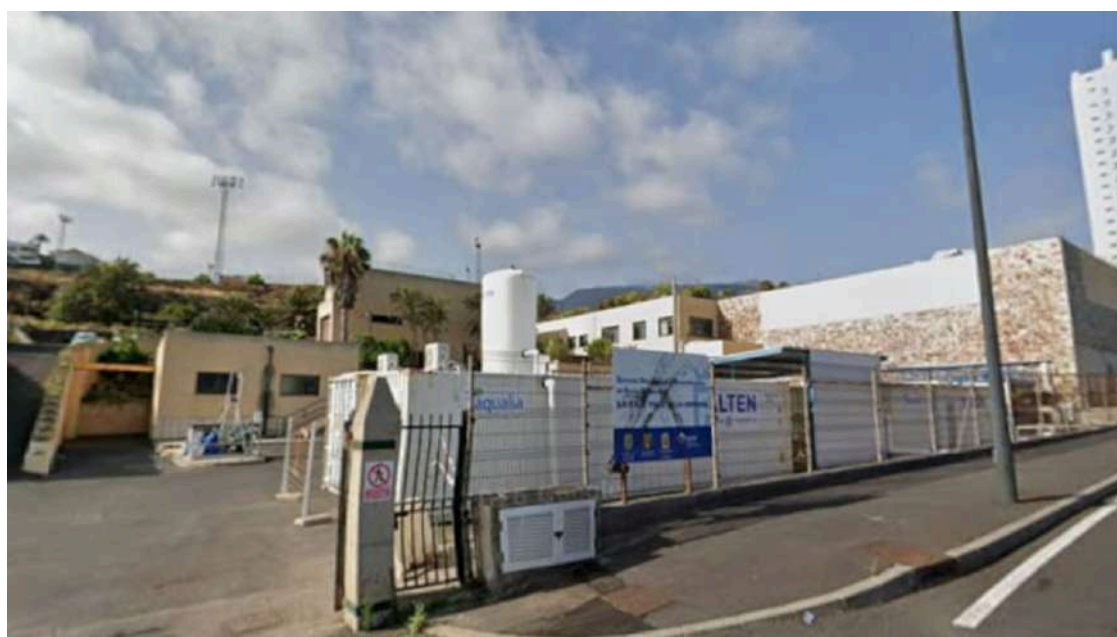
Depuradora de Punta Brava (Cabildo de Tenerife).
