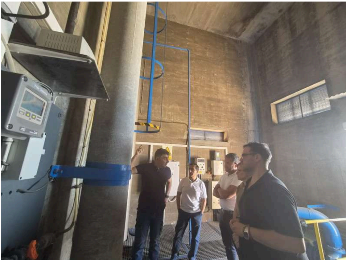
Visita a la nueva planta fotovoltaica de Torrenueva Costa (MANCOMUNIDAD)
