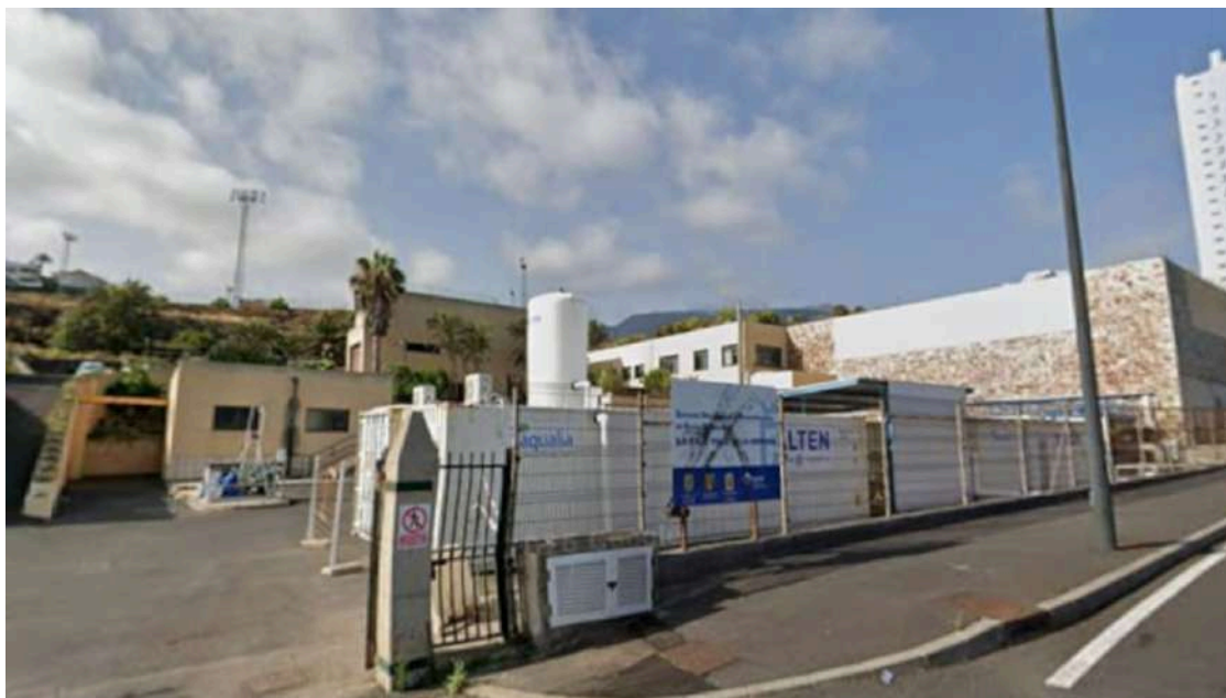
Depuradora de Punta Brava (Cabildo de Tenerife).
